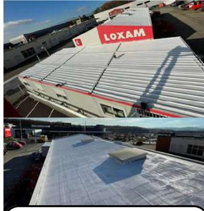
Annemasse - 2 types de toitures traitées, bacs acier et membrane bitumineuse :
